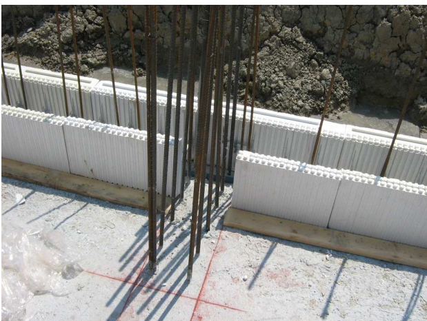
Taglio dell'elemento base per la formazione del pilastro
