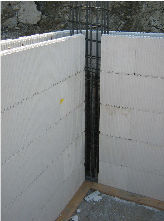
Esempi di taglio della cassetteria Argisol in corrispondenza (da sinistra verso destra) di un pilastro d'angolo e di un pilastro centrato nella parete.
