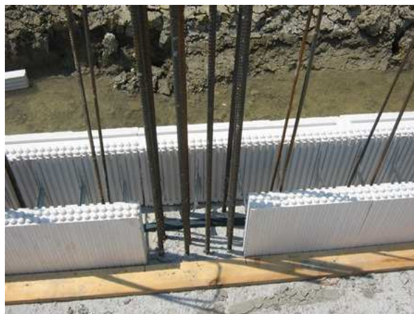
Esempi di taglio della cassetta Argisol in corrispondenza (da sinistra verso destra) di un pilastro d'angolo e di un pilastro centrato nella parete a livello della prima fila.
