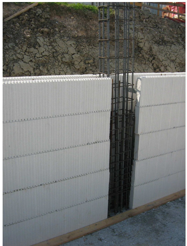
Esempi di taglio della cassetteria Argisol in corrispondenza (da sinistra verso destra) di un pilastro d'angolo e di un pilastro centrato nella parete.
