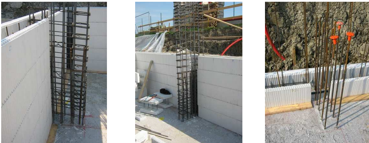
Esempi di taglio della cassetta Argisol in corrispondenza di un setto di controventamento uscente dalla parete.
