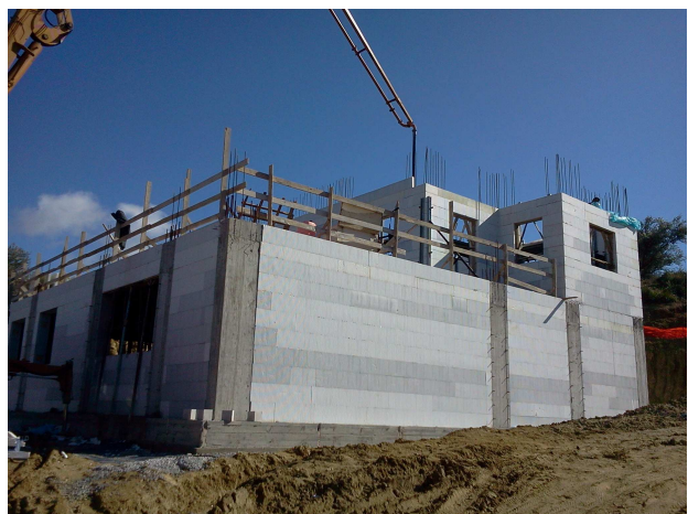
Realizzazione del tamponamento con casseri Argisol a ridosso dei pilastri
