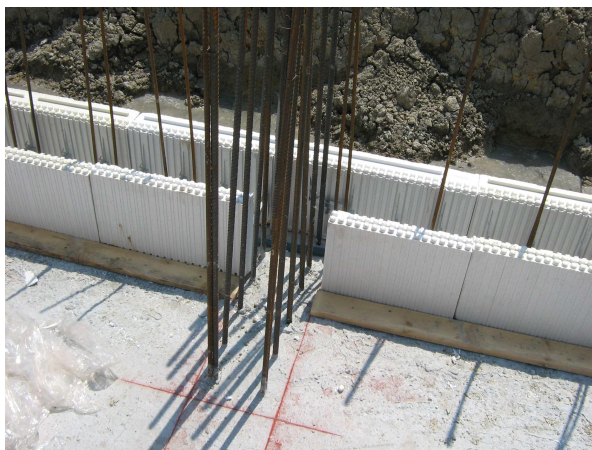
Esempi di taglio della cassetta Argisol in corrispondenza (da sinistra verso destra) di un pilastro d'angolo e di un pilastro centrato nella parete a livello della prima fila.
