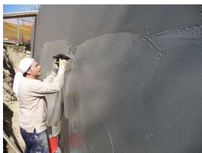
Stesa a spatola di soluzioni impermeabilizzanti liquide
