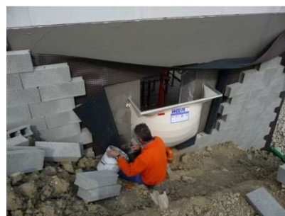
Rivestimento con guaina adesiva e protezione con blocchi
