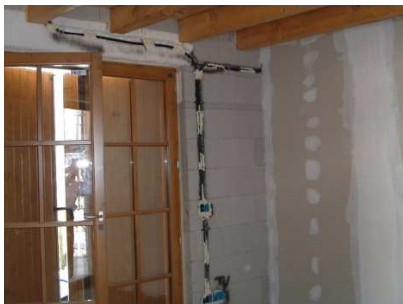
Posa delle lastre in aderenza
