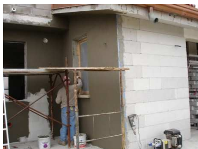
Prima rasatura della finitura "a cappotto" con rete
