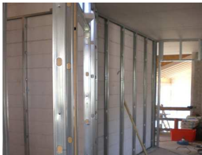
Posa delle lastre su struttura
