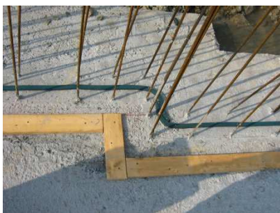
Posizionamento giunto bentonitico su platea
