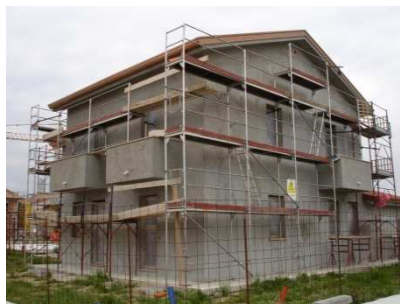
Rasatura completata. Superficie pronta per il rivestimento
