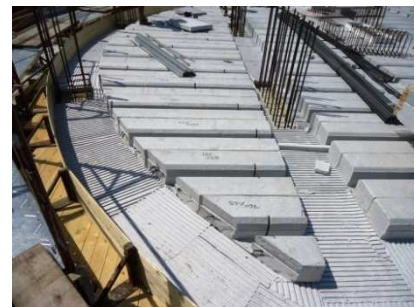
Disposizione lastre a coda di rondine
