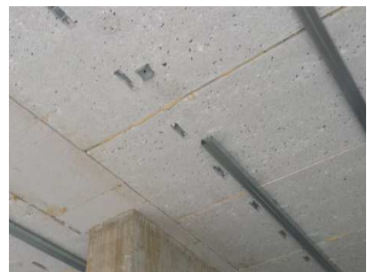
Posa della struttura di fissaggio
