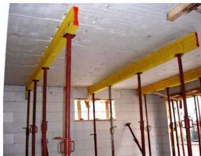
Vista dell'intradosso del solaio
