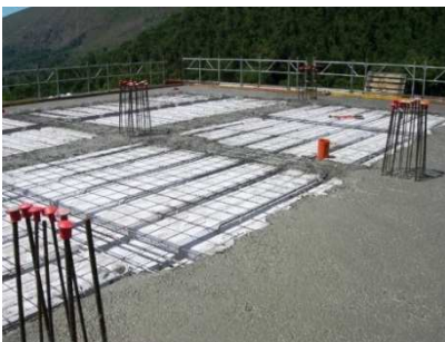
Getto di completamento del solaio
