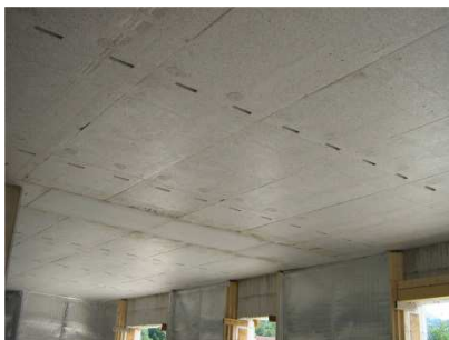
Vista dell'intradosso del solaio
