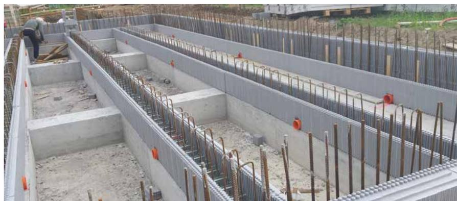
Predisposizione dei colli di fondazione con blocchi Argisol e solaio Termosolaio a vespaio
