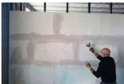
**11** Dopo un'ora, asportare la colla in eccesso e stuccare giunti e viti. Passare la seconda mano di stuccatura con il *collante PT*.
