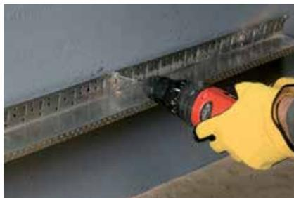
**2** Fissare il profilo *Bio Bas* come zoccolatura della parete e base di partenza per la posa delle lastre.
