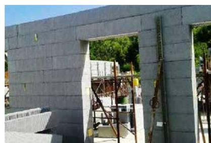
**9** In sommità delle aperture (se previsto) disporre l'elemento *Architrave*, in modo da isolare termicamente la sommità del foro finestra o porta.
