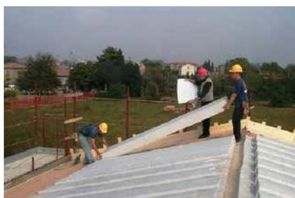
**4** Posizionare i singoli pannelli come da schema di posa concordato. Una volta posizionati sono subito pedonabili in tutta sicurezza.
