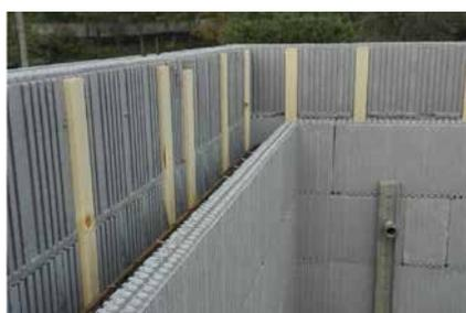
**10** In corrispondenza del cordolo del solaio disporre la lastra *Sponda solaio*. Fissarla al blocco sottostante con i *Listelli Reggisponda*.
