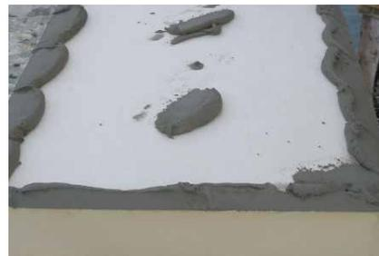
**3** Applicazione del collante *Bio Ras* sul retro della lastre isolanti in EPS e in Neopor® seguendo il "metodo del cordolo e dei 2-3 punti".
