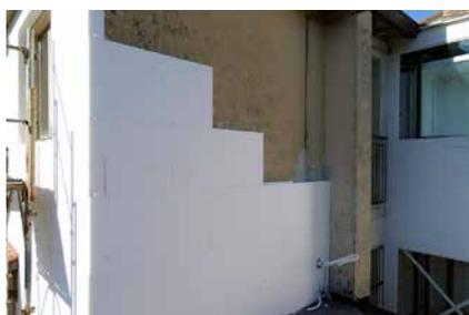
**4** Posare la lastra a ridosso della parete da isolare. Premere per far aderire la colla al supporto. Posizionare le lastre a giunti sfalsati.
