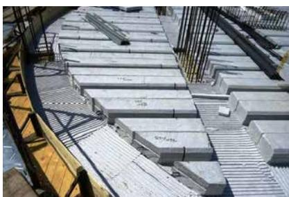
**5** Disporre nel fondo cassero delle travi a spessore le *Lastre Sottotrave* per isolare tutta la struttura di piano. Le lastre sono sagomate a coda di rondine.
