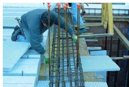
**6** Posare le armature delle travi distanziando opportunamente i ferri dalle Lastre Sottotrave a garanzia del copriferro.
