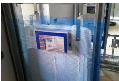
**5** Nei bagni e cucine disporre appositi sostegni per i relativi attacchi idraulici o sanitari sospesi. Le lastre sono facilmente sagomabili.
