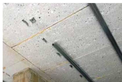
**12** A maturazione del calcestruzzo, togliere le banchine sottostanti. L'intradosso è pronto per la finitura ad intonaco o fissaggio del cartongesso.
