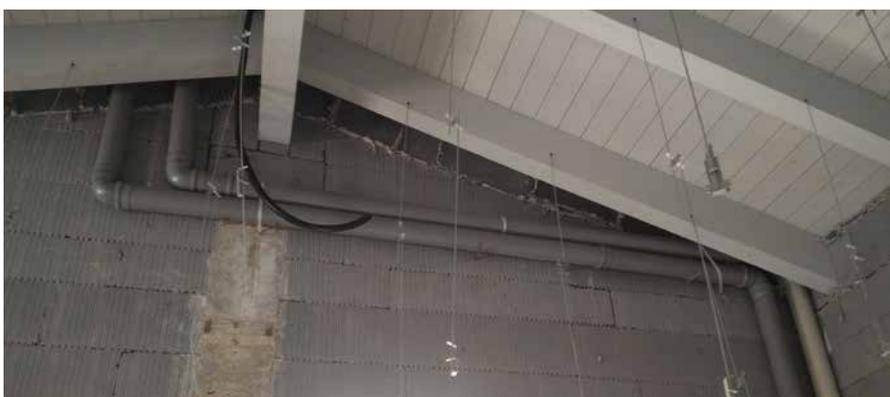
Controparete per passaggio scarichi impianti o canalizzazioni impianto di ventilazione
